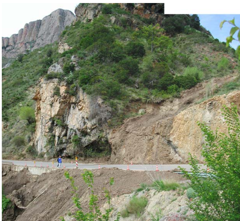
Fig. 11.13.- La zona de afección a la carretera una vez despejada. Fotografía J. M. Samsó.
