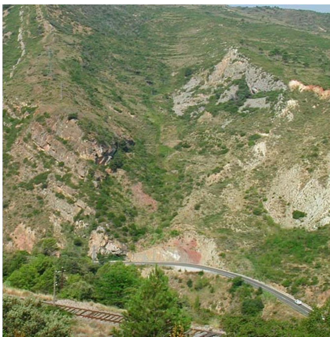
Fig. 11.5.- La zona del deslizamiento en una imagen tomada el 21 de noviembre de 2003. Fotografía de J. M. Samsó
